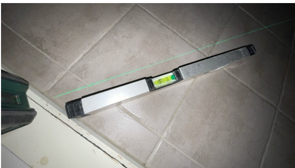
Fallforhold målt i retning sluk.
