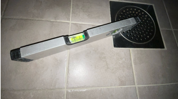
Fallforhold målt i retning sluk.
