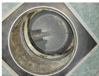
Tettesjiktets tilslutning til sluk - Hjelpesluk, bad.
