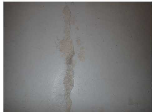
Sprekker på gulv på hobbyrom/bod
