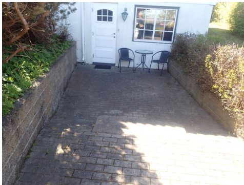
Forstøtningsmur har sprekker og skjevheter
