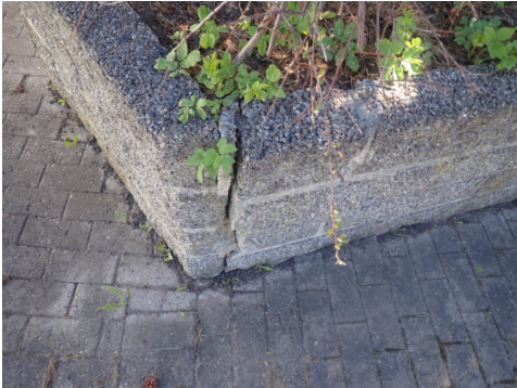
Forstøtningsmur har sprekker og skjevheter
