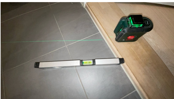
Fallforhold målt i retning sluk.
