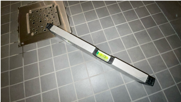
Fallforhold målt i retning sluk.
