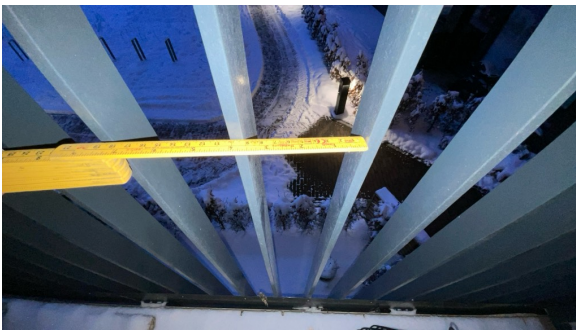
Åpninger i rekkverk.
