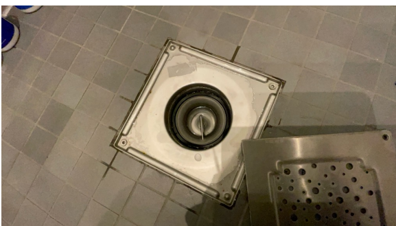
Sluk med uttagbar vannlås.
