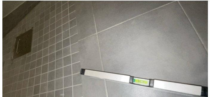
Fallforhold målt i retning sluk.
