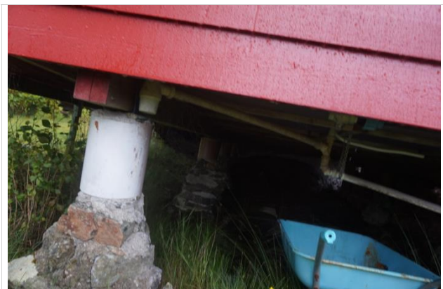
Fundamentert med betongsøyler.
