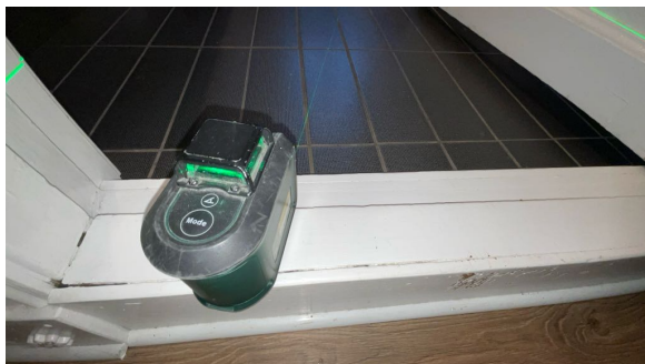
Fallforhold målt i retning sluk.
