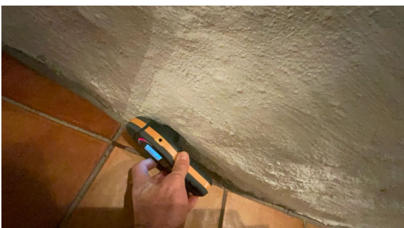
Fuktsøk med Protimeter fuktapparat.
