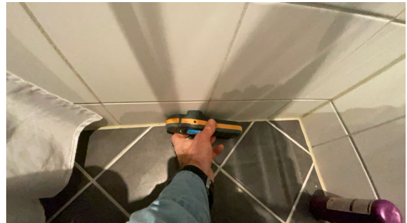
Fuktsøk med Protimeter fuktapparat.
