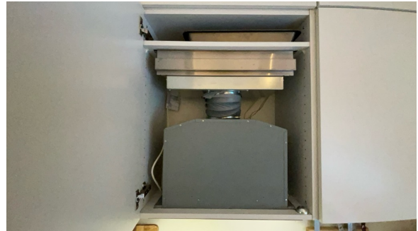
Ventilator med kullfilter.
