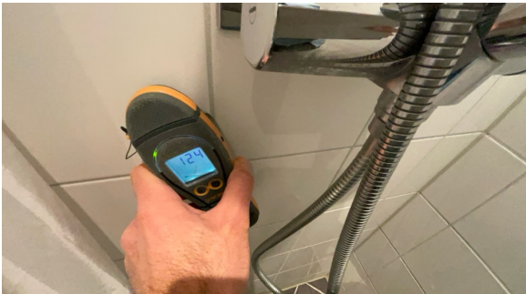
Fuktsøk med Protimeter fuktapparat
