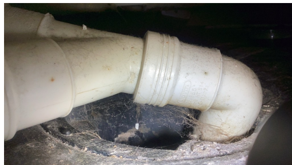
Kontroll av sluk.
