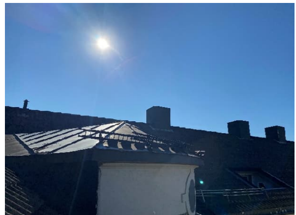
Båndtekking med malingsavflassing
