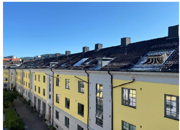
Båndtekking med malingsavflassing
