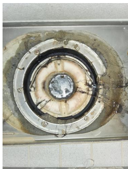
Tettesjiktets tilslutning til sluk - Sluk
