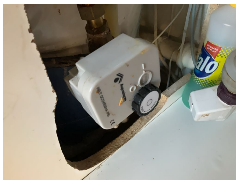
Automatisk lekkasjesikring i skap vask kjøkken
