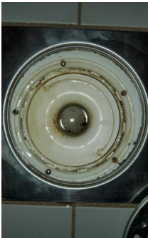
Tettesjiktets tilslutning til sluk - Sluk bad
