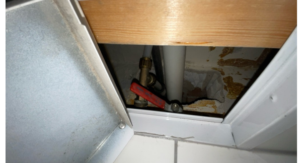
Rørpropplegg innenfor inspeksjonsluke på badetrom.
