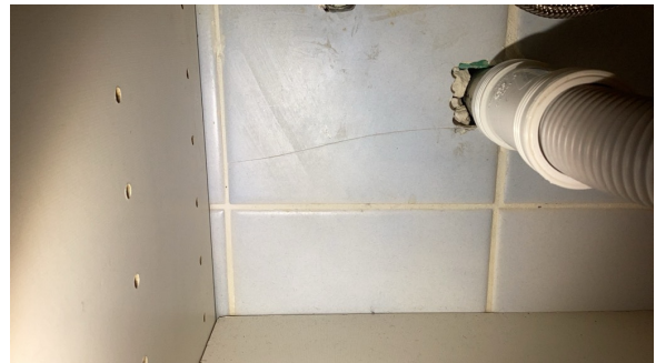
Sprekk i fliser.
