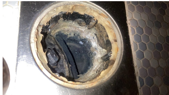
Membran lagt uten klemring i sluk.
