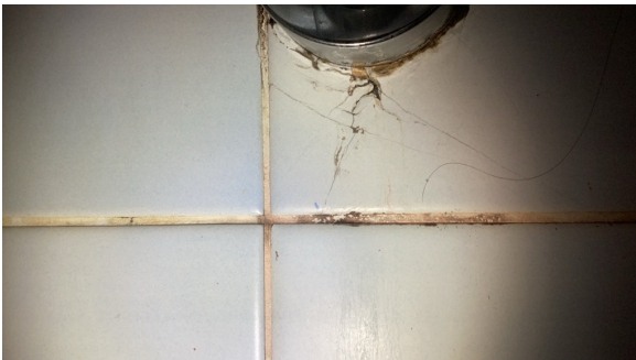
Sprekk i fliser.
