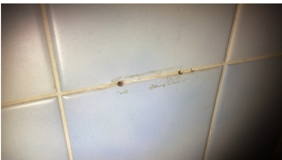
Sprekk i fliser.
