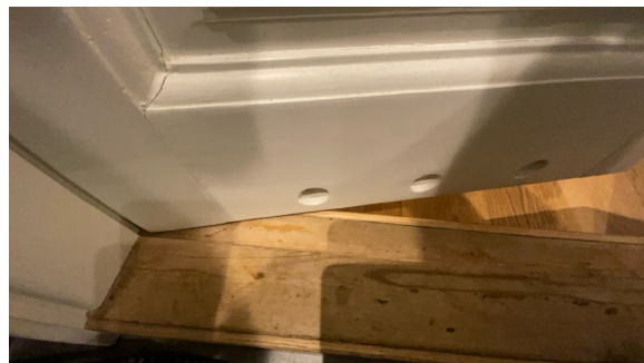
Luftespalter i dørbildet.
