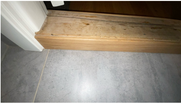
Overgang ved dørterskel.
