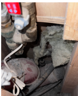
Avløpsrør. Bilde tatt gjennom inspeksjonsluke.
