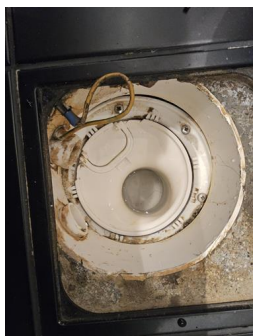
Tettesjiktets tilslutning til sluk - Sluk bad
