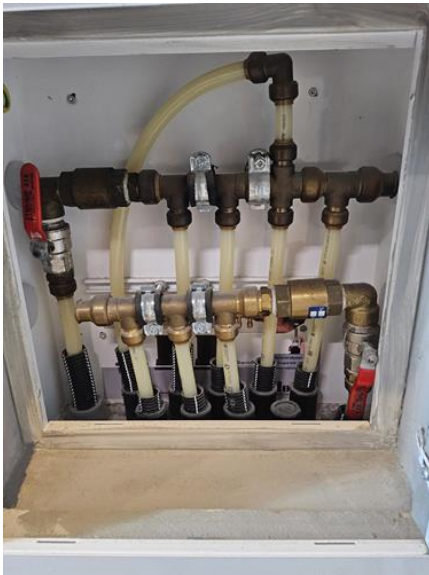
Vannrør - [Fordelerskap for rør-i-rør ]
