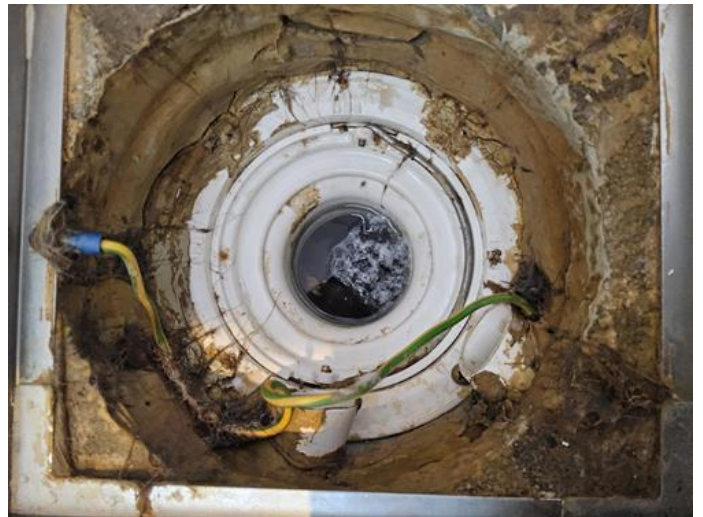
Membran, tettesjikt og overgang til sluk. - [Sluk]
