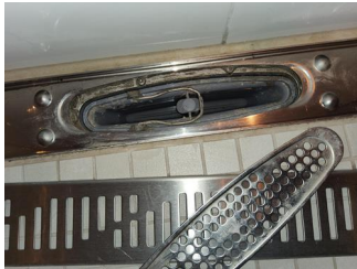
Vanntett sjikt / membran i gulv og vegger - Sluk bad 2
