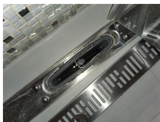
Vanntett sjikt / membran i gulv og vegger - Sluk bad 1
