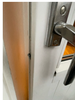
Låsetapp kommer ikke helt ut av låskassen.
