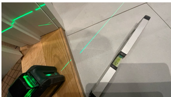
Fallforhold målt i retning sluk.
