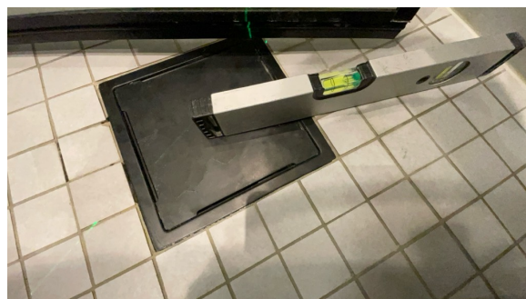
Fallforhold målt i retning sluk.
