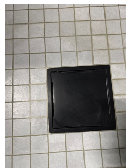
Ny slukrist og sementfuger rundt slukrist etter takstbefaring.
