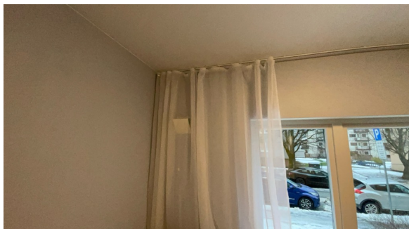
Lufteluke i yttervegg.
