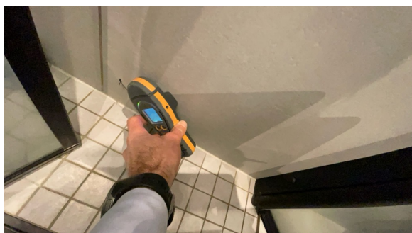
Ingen unormale utslag ved ordinært fuktsøk i dusj.
