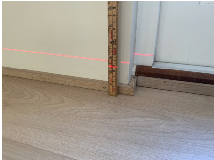
Gulv i stue: Utgang laser 30 mm, differanse fra utgang til målepunkt ca 28-29 mm.
