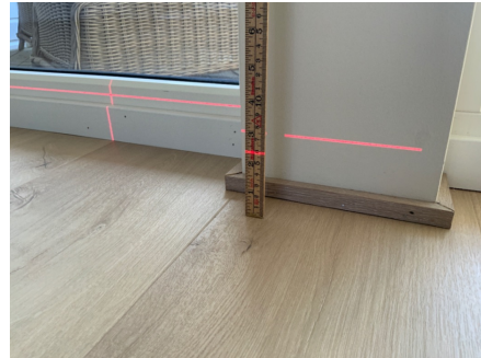
Gulv i peise-stue: Utgang laser 30 mm, differanse fra utgang til målepunkt ca 28-29 mm.
