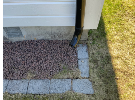
Nedløp avsluttet ved bakkenivå
