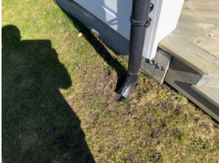
Nedløp avsluttet ved bakkenivå
