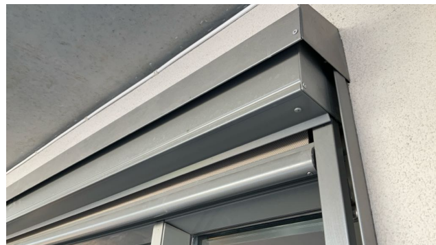
Screens på vinduer stue
