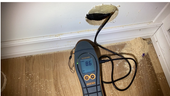
Ved fuktmåling registrerte jeg tørre verdier.
