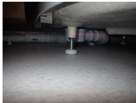
Avløp fra sluk i dusjkabinett
