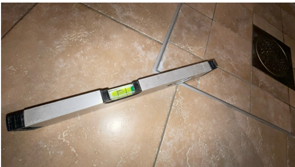
Fallforhold målt i retning sluk.
