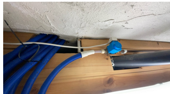
Stoppekran (blå magnetventil).
