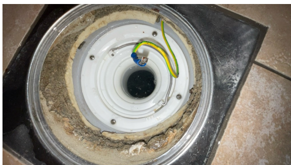
Plastsluk med synlig dukmembran.
