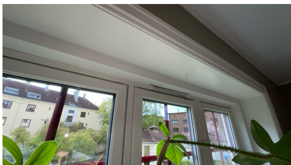
Luftespalter over vinduer.
