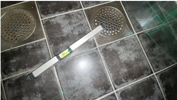
Fallforhold målt i retning sluk.
