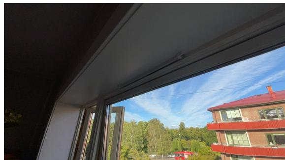
Luftespalte over vindu.
