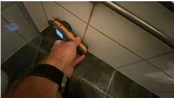
Fuktsøk langs sokkel med Protimeter fuktapparat.
