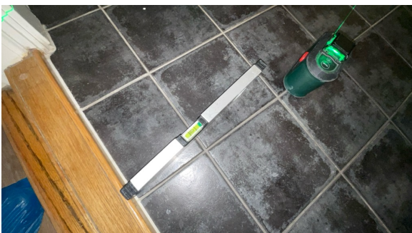
Fallforhold målt i retning sluk.
