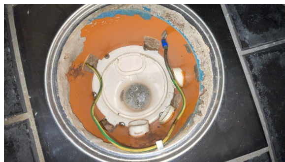
Hovedsluk. Jordingskabel må festes (klemmes) bedre til slukristen.
