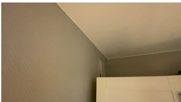
Opprinnelig lufteluke i sjakt på kjøkkenet anbefales å holdes åpen.
