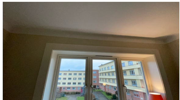
Luftespalte over vinduer.
