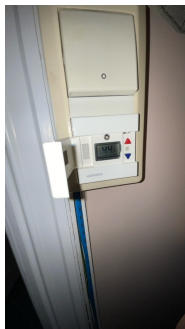
Termostadbryter for varmekabler.
