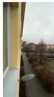
Avtrekksluften er ført til lufterventil i yttervegg.
