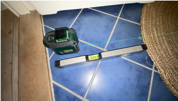
Fallforhold målt i retning sluk.
