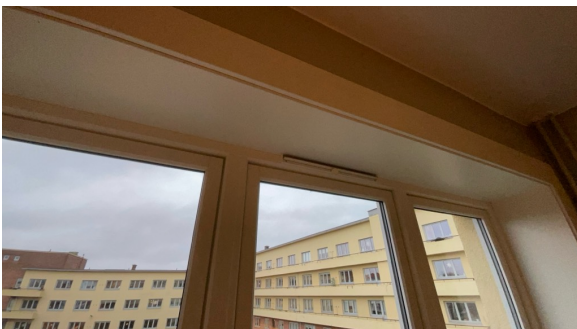
Luftespalte over vinduer.
