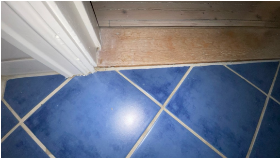
Overgang ved dørterskel.
