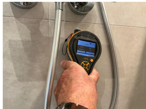
Søk etter fuktvariabler med fuktsøk i vegger/gulv våtsone bad. Apparat benyttet er Protimeter MMS 2.
