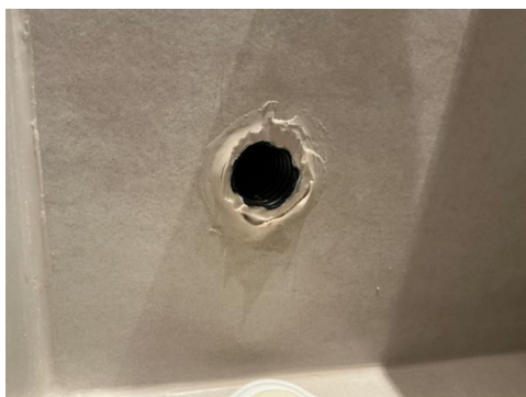
Drensåpning vegg fordelerskap
