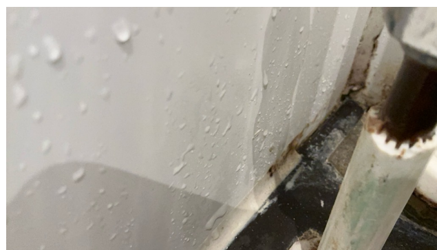
Gjennomføring gulv dusjsone
