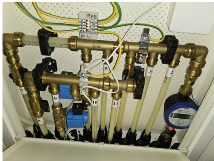
Tekniske anlegg, VVS anlegg (Sjekkpunkter utover det som er inkludert i andre rom) - [Fordelerskap innvendig bod]
