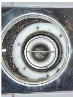
Tettesjiktets tilslutning til sluk - Sluk
