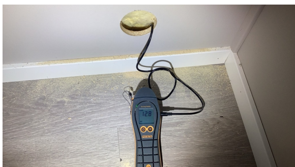
Ved fuktmåling registrerte jeg tørre verdier.
