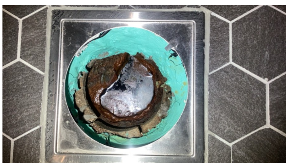
Kontroll av sluk.
