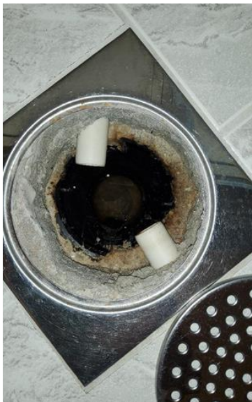
Membran, tettesjikt og overgang til sluk. - [Sluk bad 2.etasje ]
