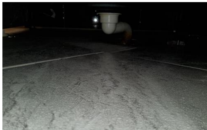
Membran, tettesjikt og overgang til sluk. - [Sluk bad 2.etasje ]
