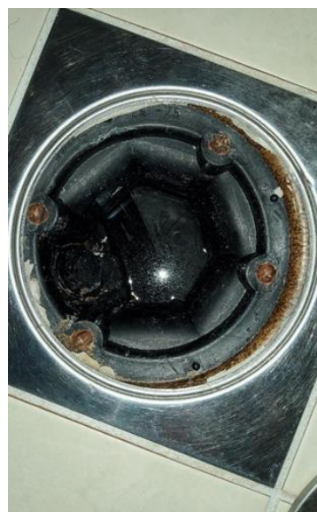
Membran, tettesjikt og overgang til sluk. - [Sluk bad underetasje ]
