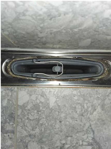
Våtrom - [Sluk bad 1]
