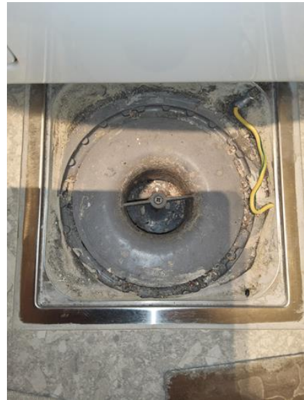
Våtrom - [Sluk vaskerom]
