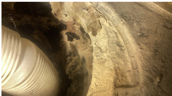
Kontroll av sluk.
