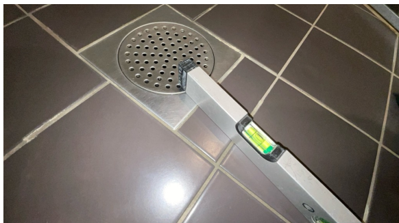
Fallforhold målt i retning sluk.
