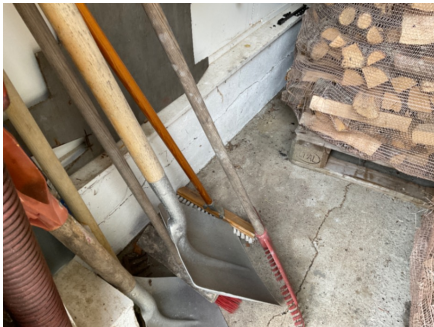
Sprekk i gulv i garasje.
