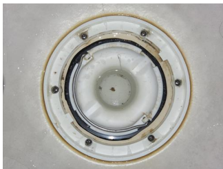
Tettesjiktets tilslutning til sluk - Sluk på baderom i 3.etasje
