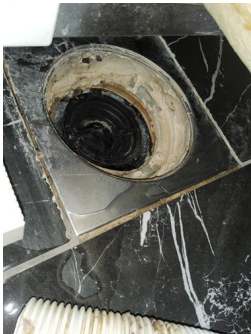
Tettesjiktets tilslutning til sluk - Sluk på baderom i 2.etasje
