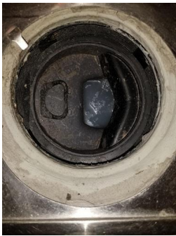
Tettesjiktets tilslutning til sluk - Sluk vaskerom
