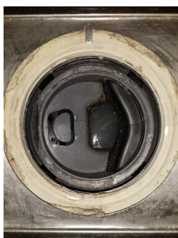
Tettesjiktets tilslutning til sluk - Sluk bad 1.etasje
