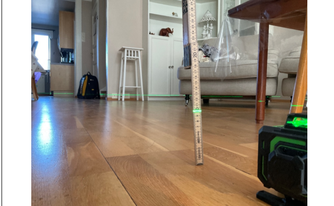
Nivellering av gulv. Kontroll av skjevhet.
