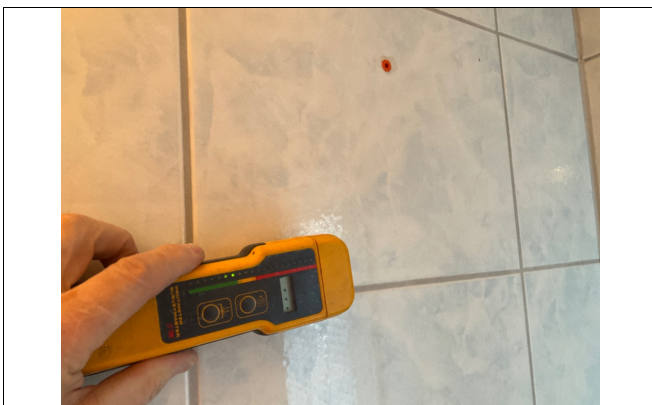
Kontrolløk med fuktmåler i dusjonen.
