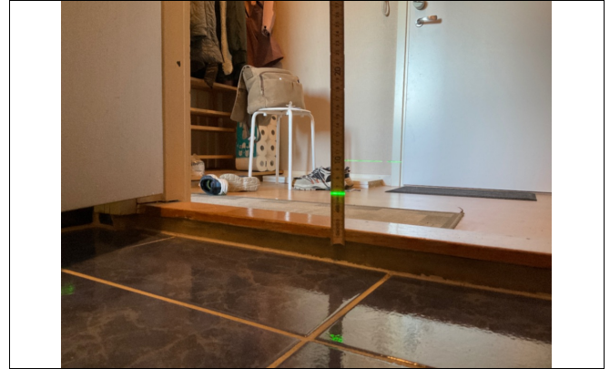
Kontroll av fall på gulv i bad.
