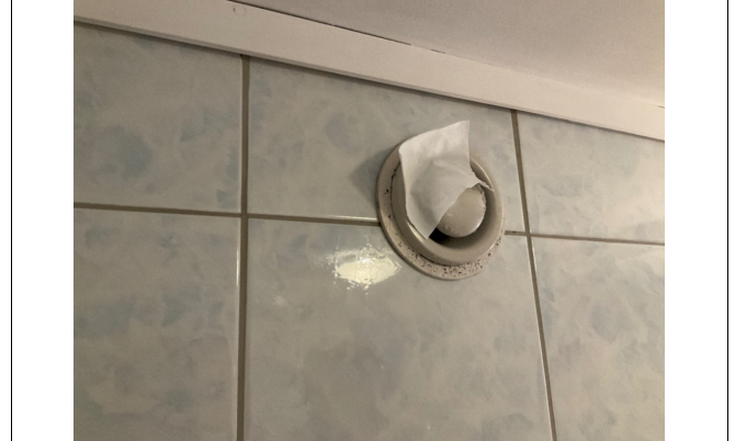
Kontroll av avtrekk på bad.
