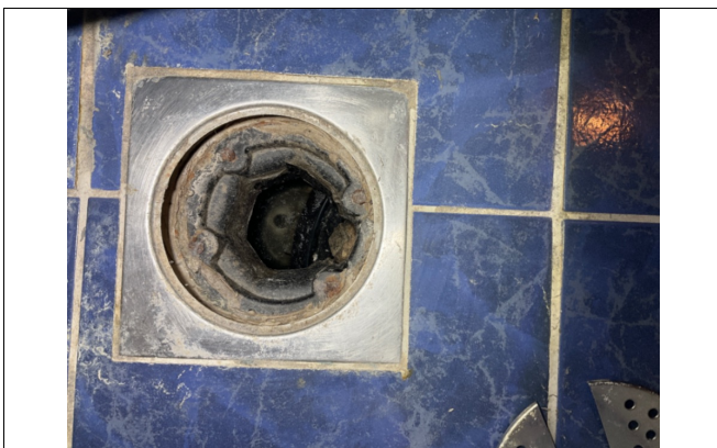
Kontroll av sluk.
