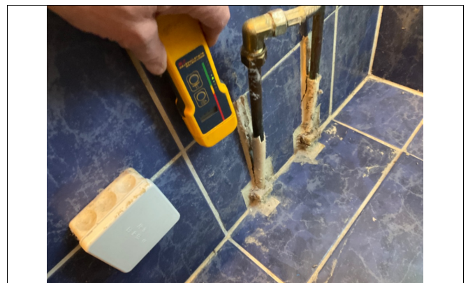
Kontrolløk med fuktmåler i dusjonen.
