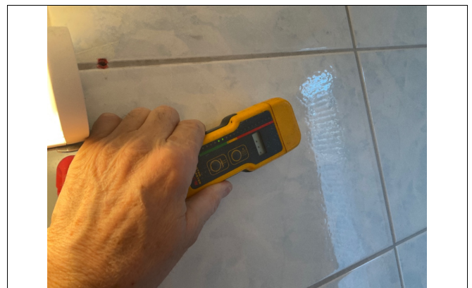
Kontrolløk med fuktmåler i dusjonen.
