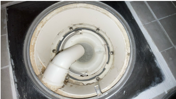
Synlig dukmembran under klemring.
