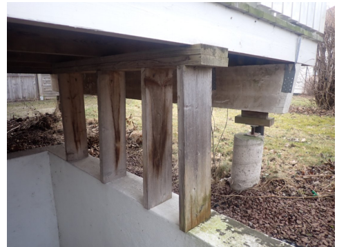
Det er etablert midlertidig bæring ned mot mur til nedgang kjeller.
