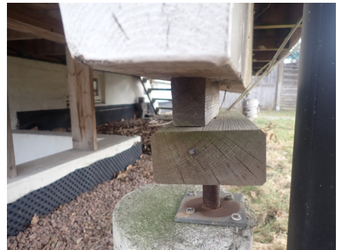
Det er etablert løse klosser mellom fundament og drager
