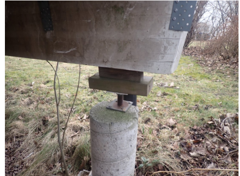
Det er etablert løse klosser mellom fundament og drager
