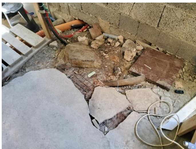
Beskrivelse - [Gulv i underetasje.]
