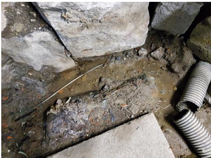
Rom under terreng (kjeller, underetasje, sokkeletasje) - [Fuktinnsig i underetasjen.]
