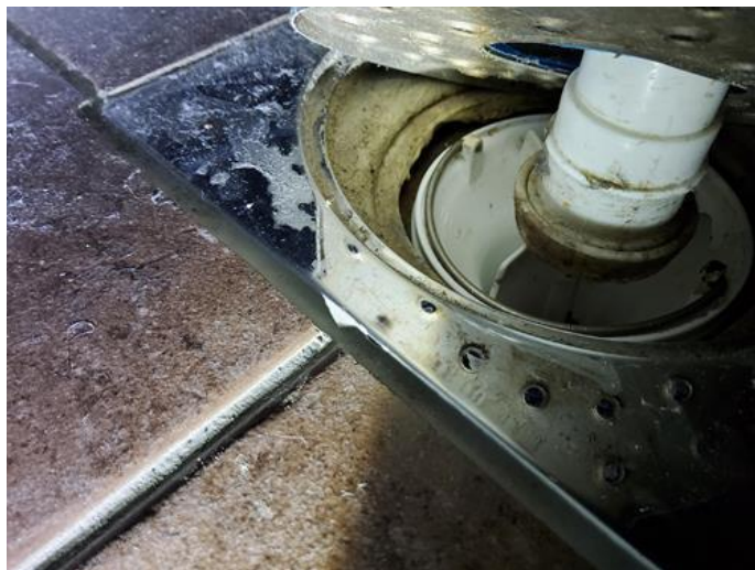
Membran, tettesjikt og overgang til sluk. - [Sluk i rom benyttet som bad.]
