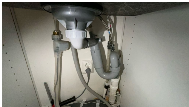
Synlige rør under kjøkkenbenken.
