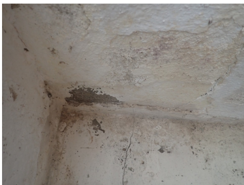
Synlig saltutslag på åpen mur i flere kjellerrom.
