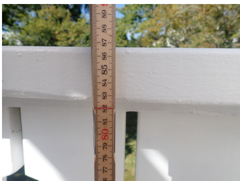
Høyde rekkverk 87 cm.
