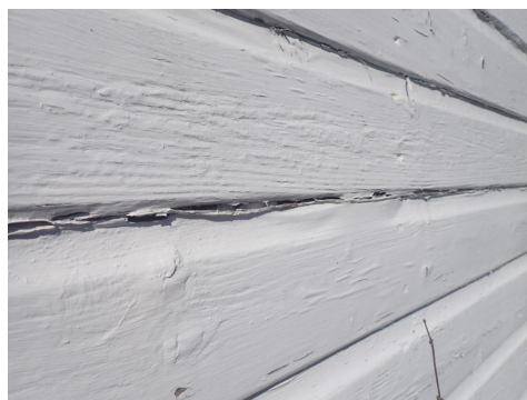
Kledning på fasade øst.
