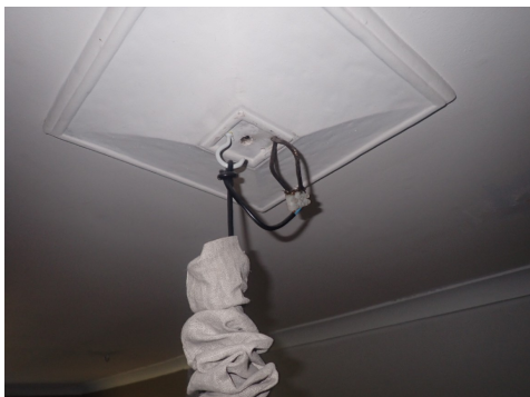
Åpne ledninger i kobling uten beskyttelse soverom i 2. etasje
