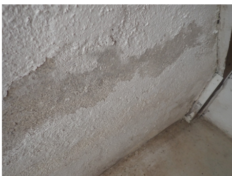
Synlig saltutslag på åpen mur i flere kjellerrom.
