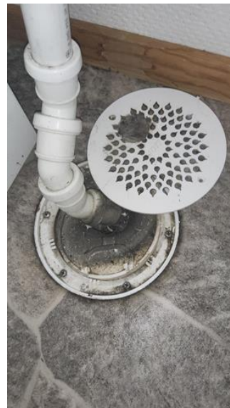
Våtrom - [sluk vaskerom]
