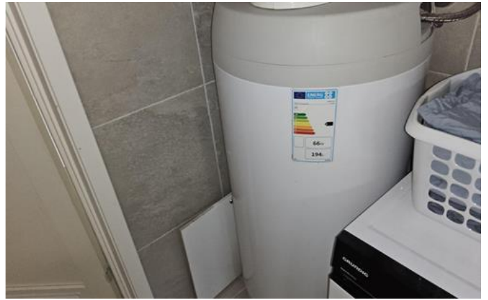
Varmtvannsbereder (Sjekkpunkter utover det som er inkludert i andre rom) - [Varmtvannsbereder.]
