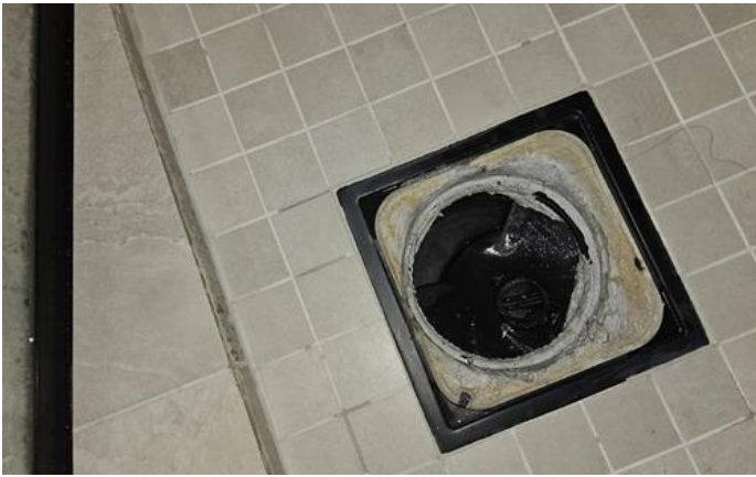
Membran, tettesjikt og overgang til sluk. - [Sluk i dusjonen.]
