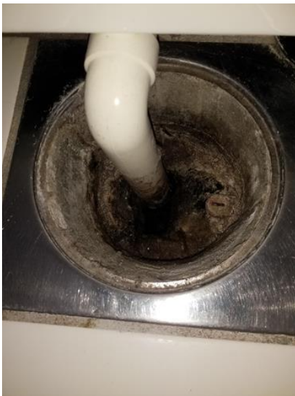
Kommentar - [Sluk bad, innredet loft ]
