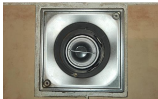
Avløp (inkl. sluk) - Sluk bad
