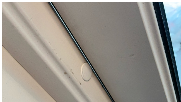
Synlig spalte mellom dørblad og karm.
