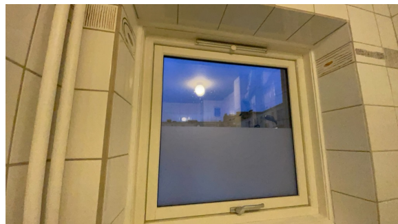
Vindu på bad.
