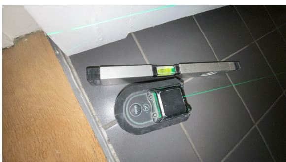
Fallforhold målt i retning sluk.
