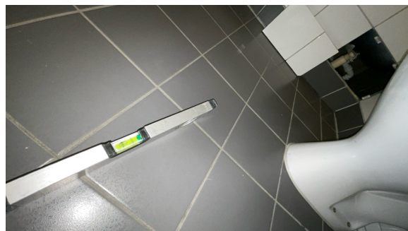
Fallforhold målt i retning sluk.
